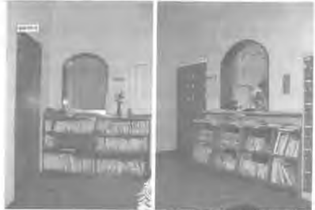
▲写真1 玄関ホール付近の様子
